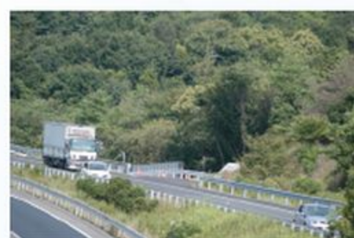
緊急用開口部 上り
