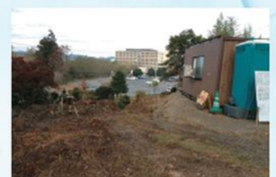
病院への進上路（工事中）
