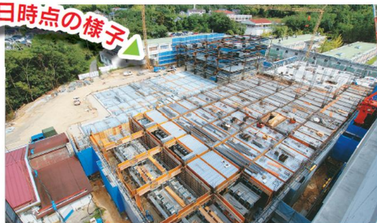
▲病棟屋上からの撮影
