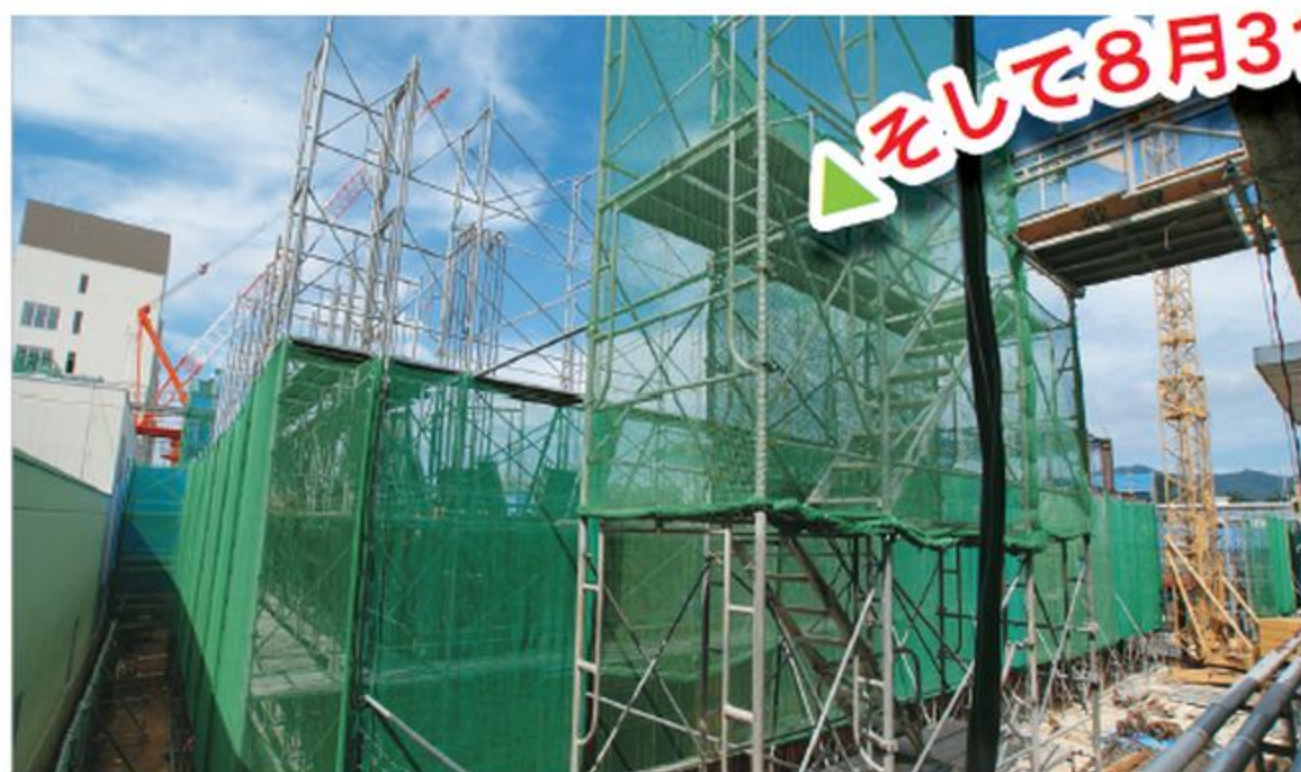
▲中央廊下2階からの撮影
