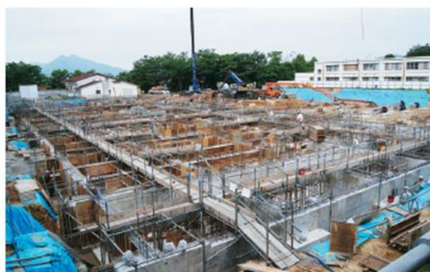
▲中央廊下2階からの撮影
