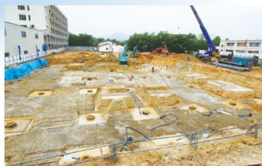
▲杭打ちの状況です。
