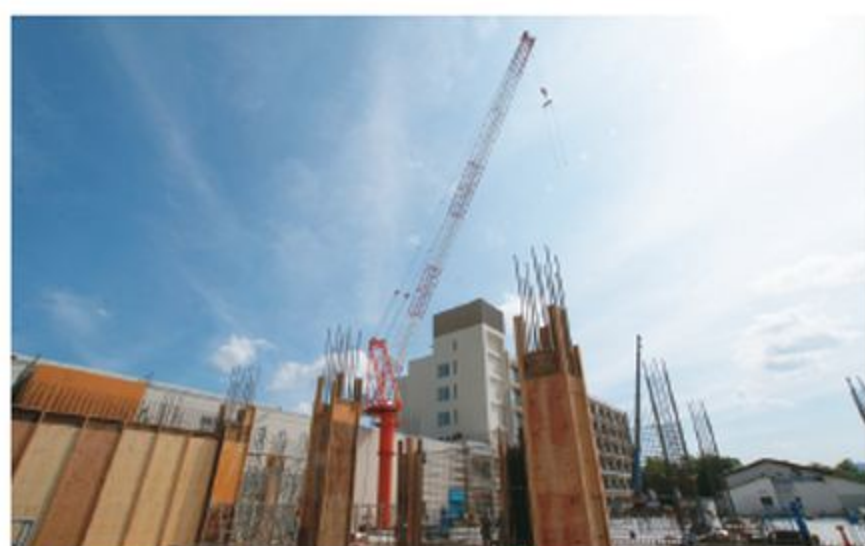
▲高くそびえ立つクレーン
