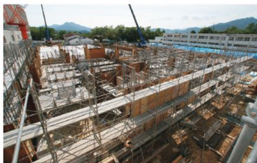
▲中央廊下2階と新外来棟の2階は高さが合わず、手術室の高さと合うよう設計されているそうです。
