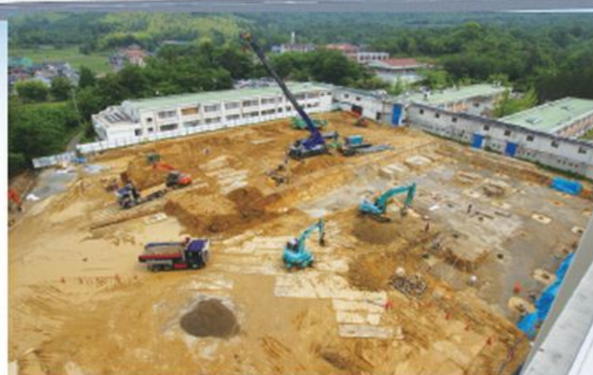
▲新病棟の屋上から撮影しました。
