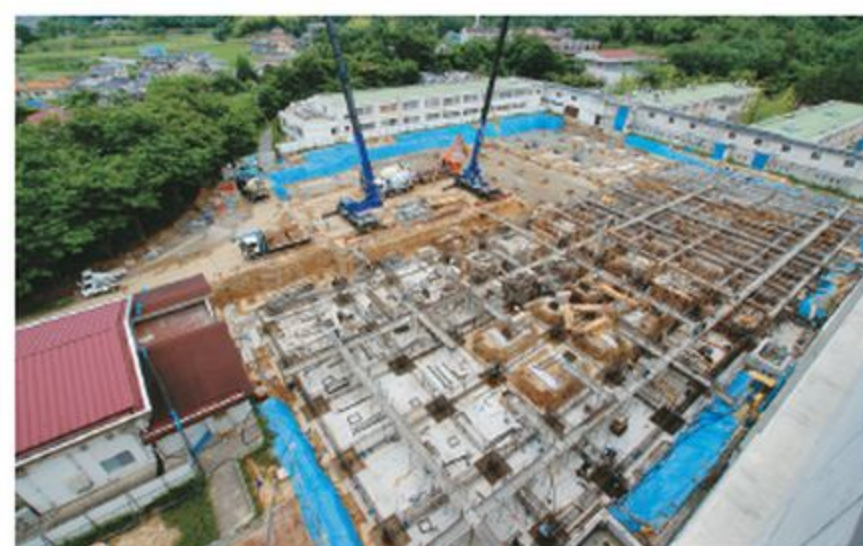
▲病棟屋上からの撮影
